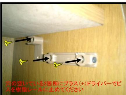
穴の空いている3箇所にプラス(+ )ドライバーでビスを樹脂レールに止めてください
