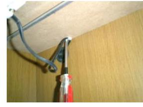
② 電源コードを固定している「コード止め」を外して下さい。(ドライバーでねじを外)
