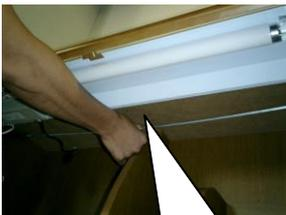
③ 灯具を手前に引出し「連動バー」を後方に弓状押しすと両端の保持部から外れる
